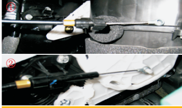
37 将空调拉线固定到原来的位置
