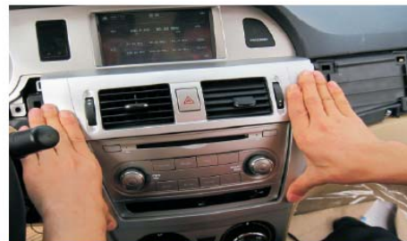
26 连接空调面板后面插座，并装好空调面板
