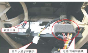
17 对插上马3专用转接线；安装导航天线
