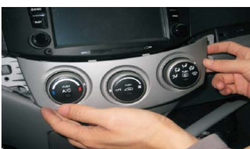
17 装上空调控制面板
