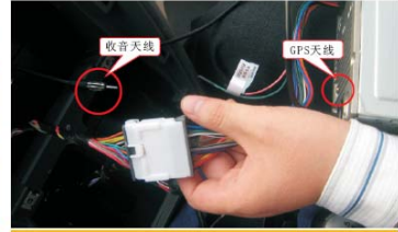
21 接好电源线、GPS天线、收音天线
