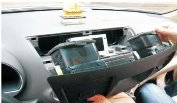
07 取出空调通风口
