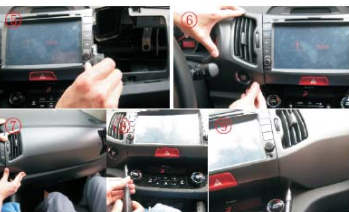
14 接好线后，装入主机，通电测主机各项功能，OK后，分别装紧左右中控盖。
