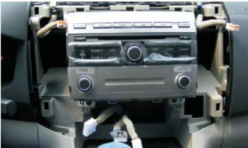
11 拆除外框后状态
