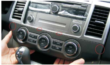
04 从空调盒下侧开始拆外框(红色标识处为扣的位置)
